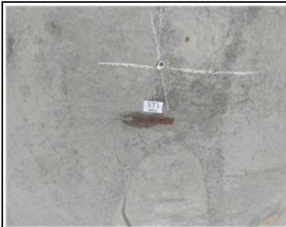
변형률계 설치 현황
