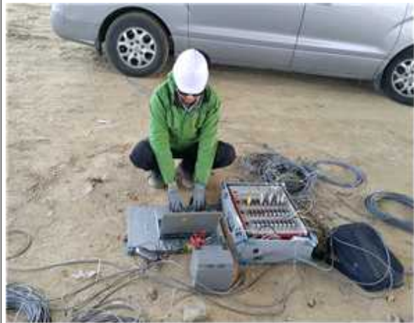
재하시험 계측 전경
