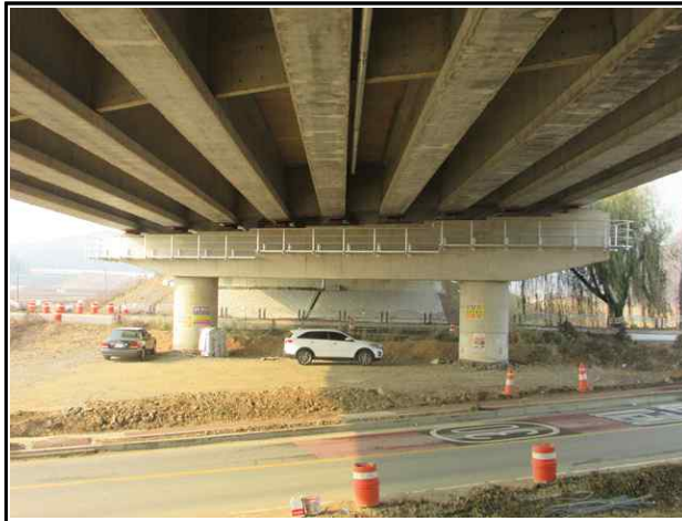
교각 P1 전경
